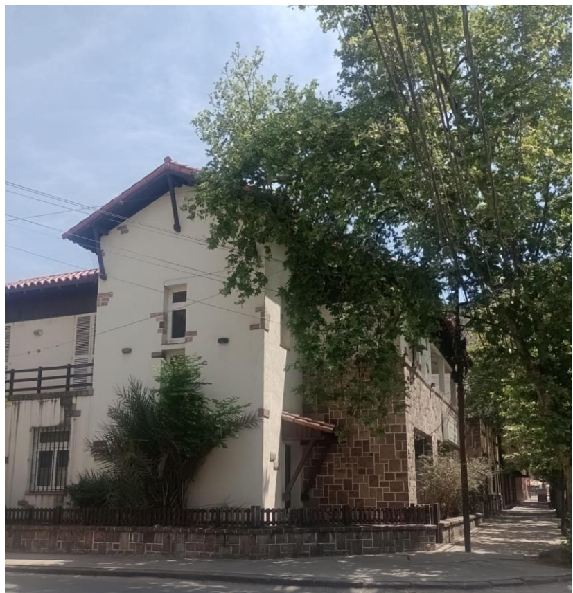
Fachada externa de Casa de Piedra. Lugar donde funciona la Unidad de Educación para la Salud
