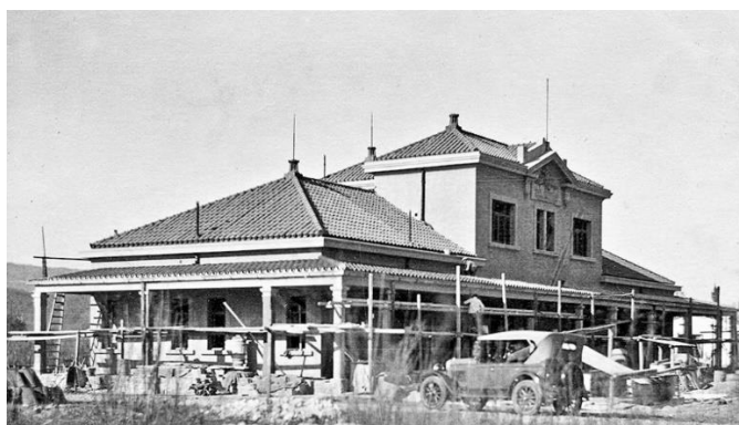
Figura 4 Edificio en construcción MEPRA julio de 1929 (Archivo Fotográfico Salvador Mazza – Clorinda Razori, en web de Julio Linares 93 )
