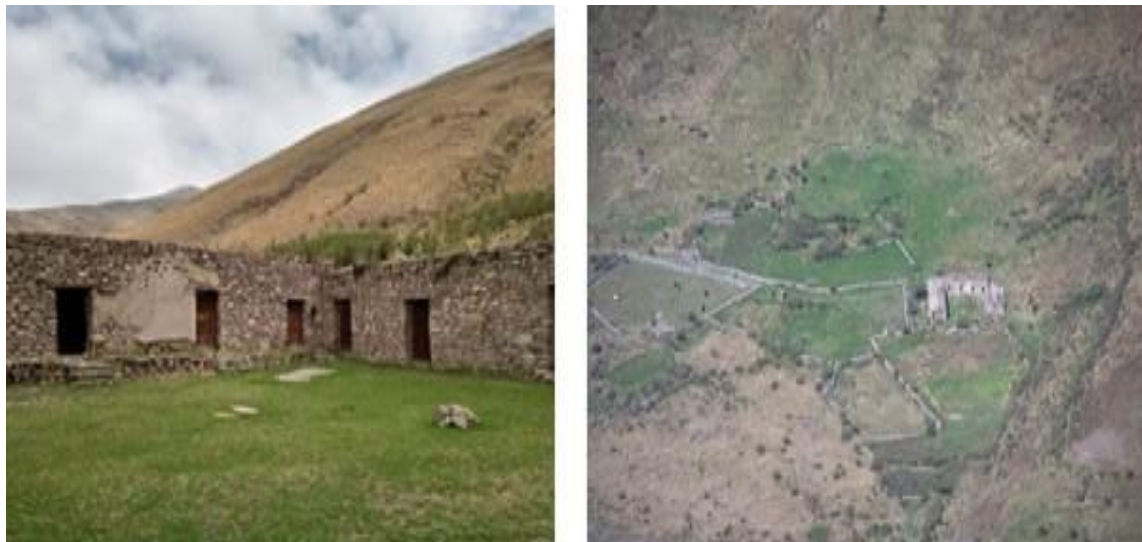
Foto 24: Predios en ruina de la Mina El Porvenir. Cerro Purma
