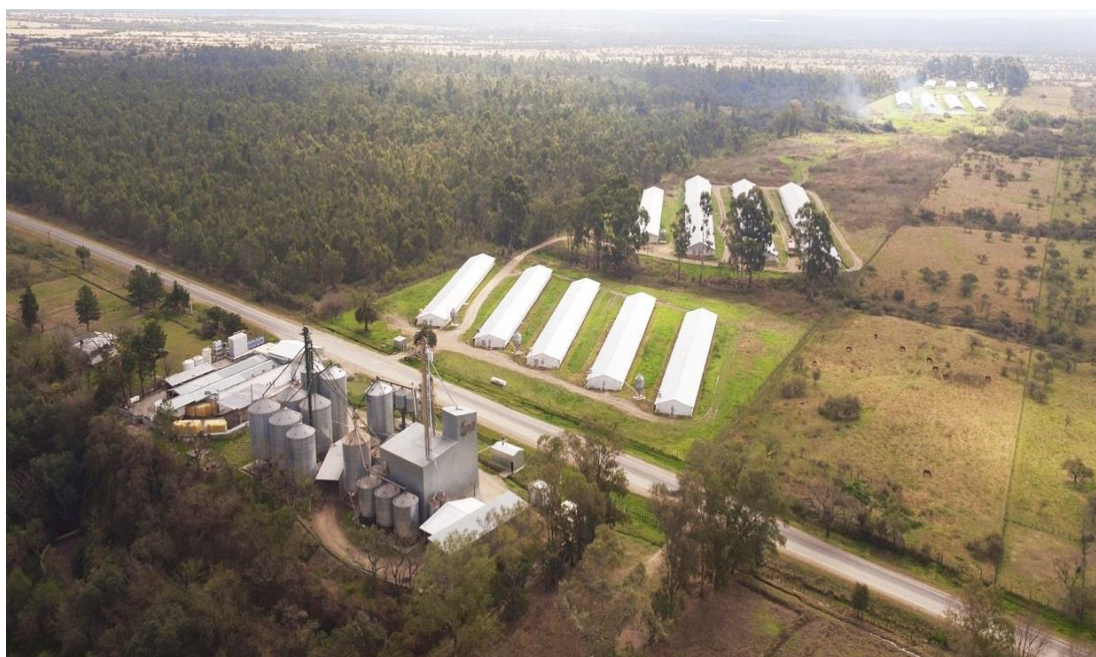
Foto 16: Predio producción avícola. Ruta prov. Nº2 La Toma-Departamento San Antonio
