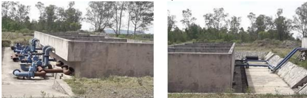
Foto 28: Estructura de piletas de la nueva planta potabilizadora de agua en proceso de construcción. Los Morados – Departamento San Antonio
