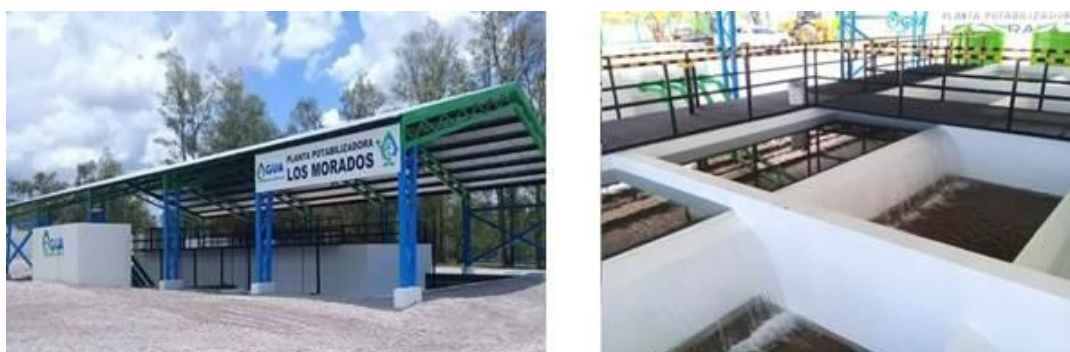
Foto 29: Nueva planta potabilizadora de agua Los Morados – Departamento San Antonio
