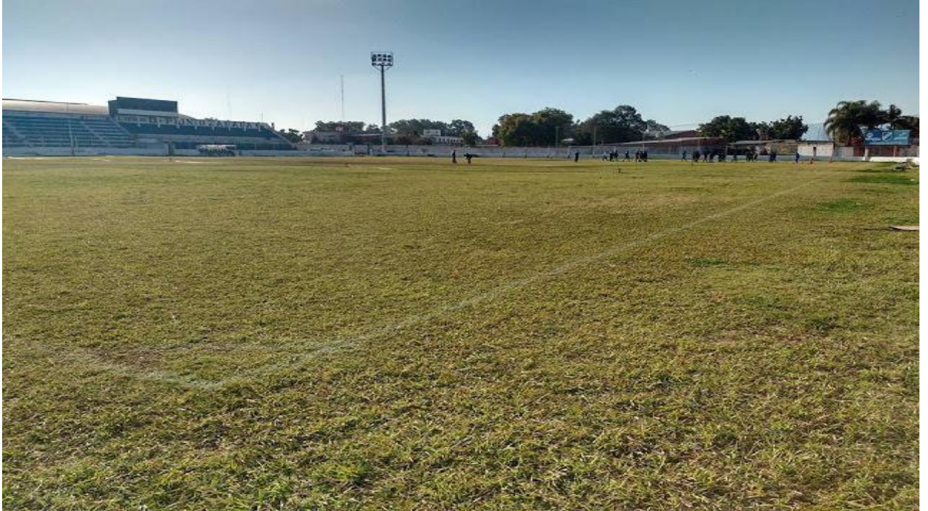
Foto 5. Tribunas platea, preferencial, y torre de iluminación.
