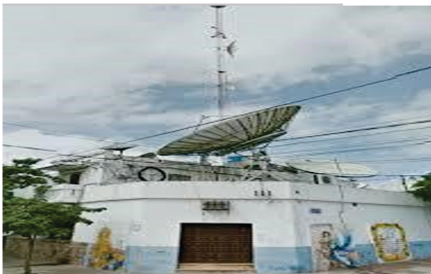
Imagen de archivo, del ingreso antiguo al edificio de la empresa Cable audio visión sobre Calle Paterson N° 408 que fuera refaccionado y rediseñado en el año 2018
